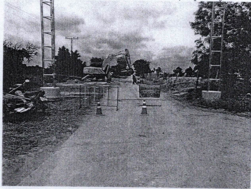
ภาพซ่อมแซมถนนคอนกรีตเสริมเหล็ก บ้านเกษตรสมบูรณ์ หมู่ที่ ๖
